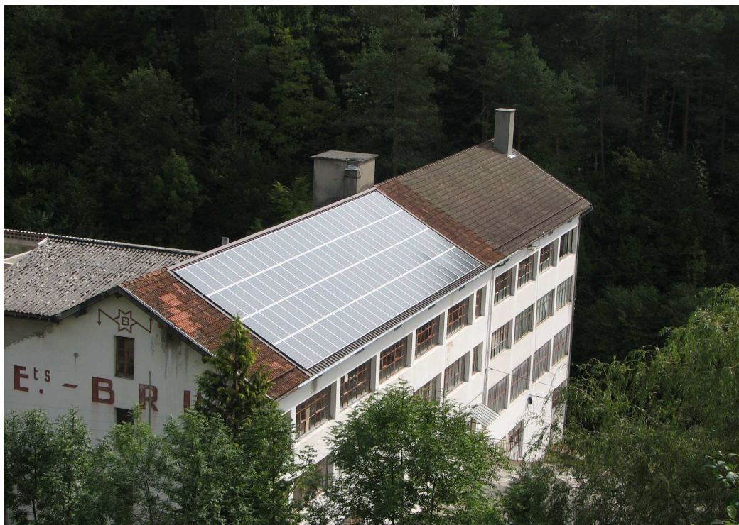
Vue sur le toit sud de l'usine avec les 138 m 2 de modules
